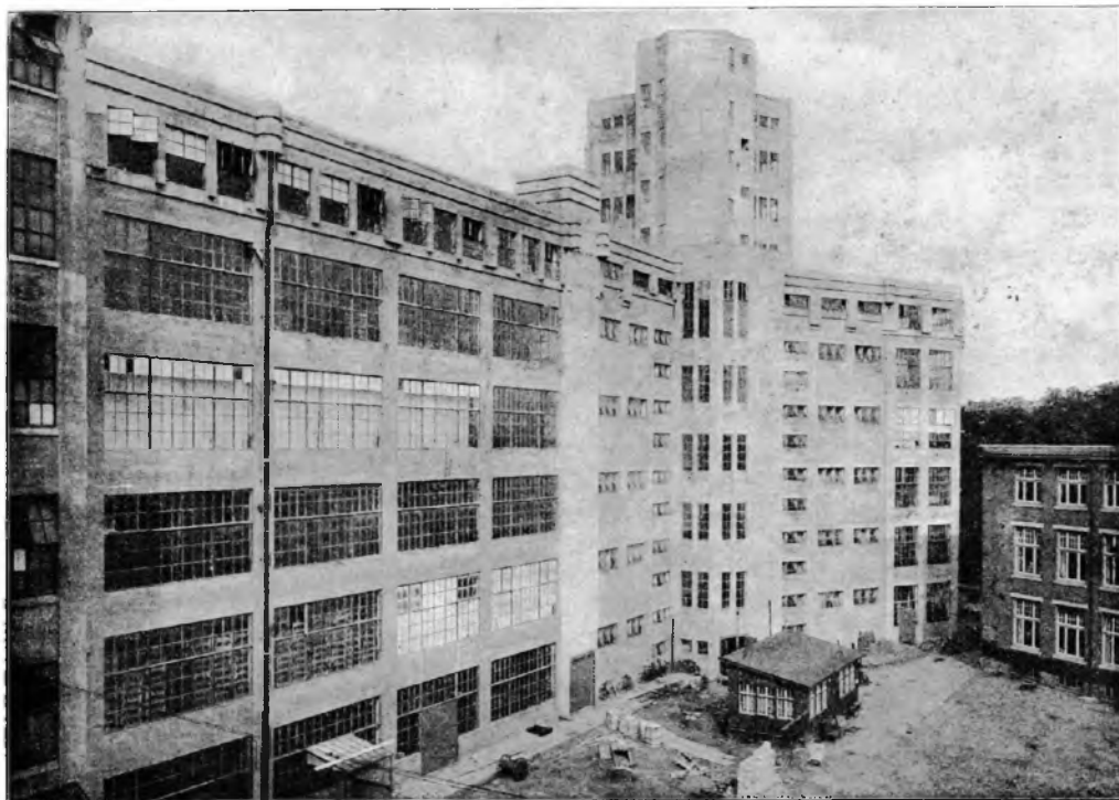
Binnenplaats groote fabriek met een kijkje op den 65 Meter hoogen toren.
